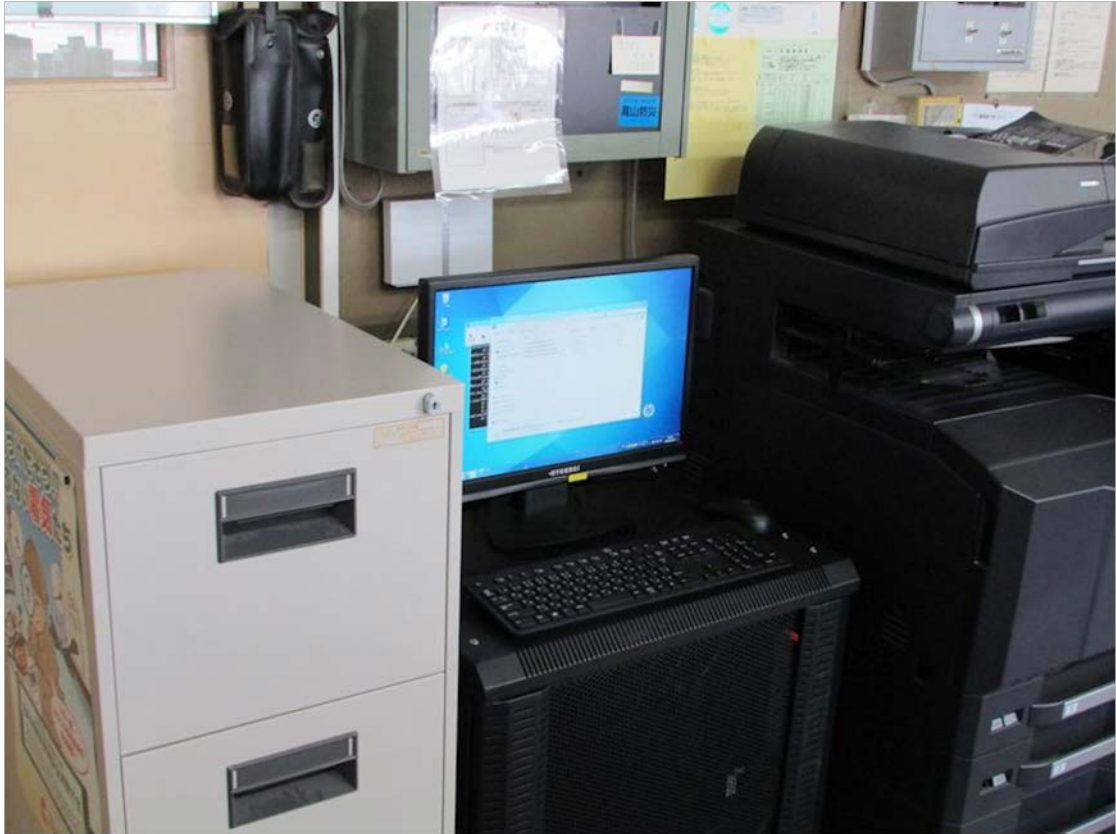
図-2.2 栃尾小学校職員室に設置した雨量観測システム用サーバ
